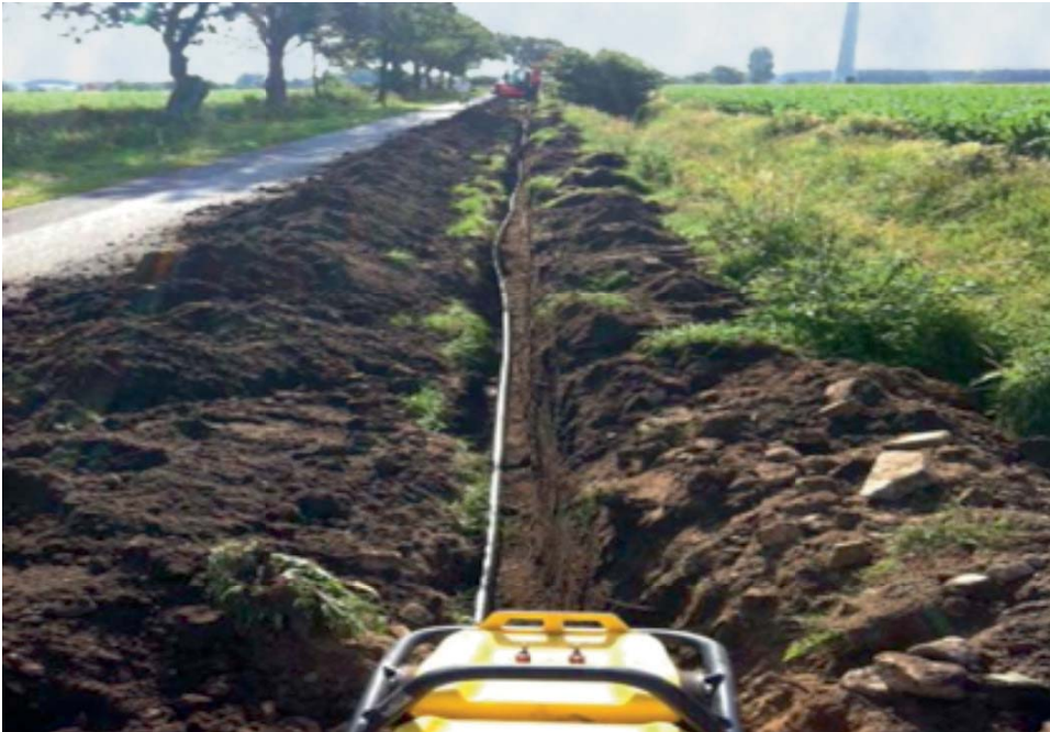
Abb. 2: Weite Strecken im Ausbaubereich der BNG
