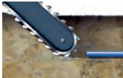
Das Fräsverfahren hat die gleichen Vorteile wie das Pflugverfahren mit dem Unterschied, dass das Verfahren bis Bodenklasse 7 eingesetzt werden kann und die Verlegeleistung geringer ist.
