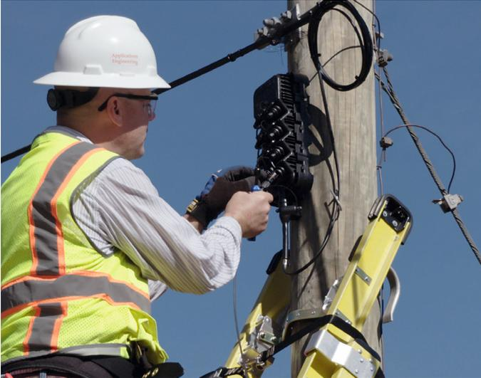
Abbildung 8: Patch-Muffen sind speziell konzipiert für die unkomplizierte Installation am Mast und den schnellen Kundenanschluss.
