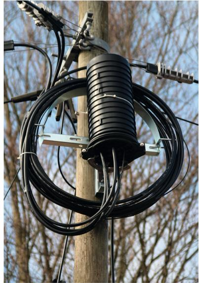
Abbildung 7: Eine Abzweigmuffe mit Überlängenspeicher nach der Installation.
