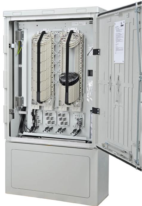
**Abbildung 4:** Glasfaser-Netzverteiler bilden den Übergang zwischen Hauptnetz und Kundenanschluss.
