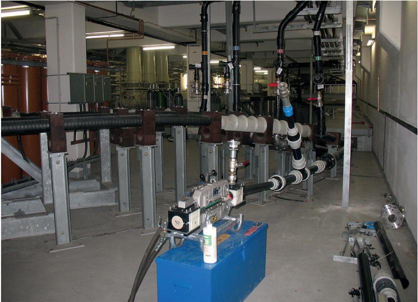
Bild 2: Installation mit SuperJet™ im Eingang einer 400 KV-Umspannung
